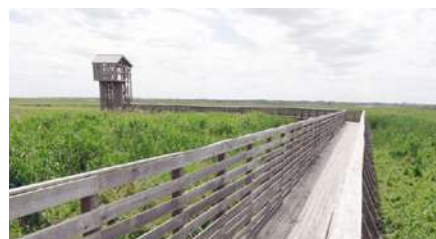
Traverser des milieux ouverts avec vues sur les vallées alentours
