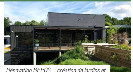
Rénovation BEPOS _ création de jardins et cultures en toiture _ Diagonale concept
