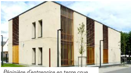
Pépinière d'entreprise en terre crue _ Gonfreville L'Orcher
