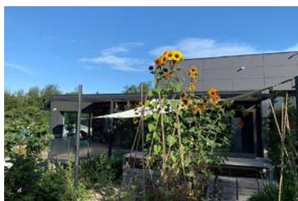
Réhabilitation : IPE, installation de panneaux photov., aménagements d'espaces extérieurs,
